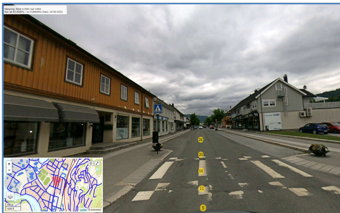
Foto: Kv3451 Orkdalsveien
