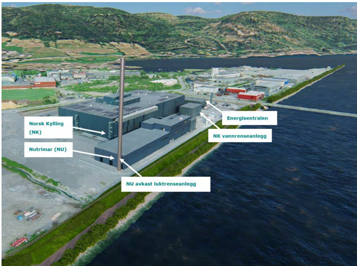
Figur 3: Illustrasjon av det planlagte anlegget til Nutrimar på Furumoen, Orkanger (eiendom med gnr./bnr. 257/340) og oversikt over de andre virksomhetene/enhetene på området. Produksjonsanlegget i bygningen bak anlegget til Nutrimar driftes av Norsk Kylling og de har eget vannrenseanlegg. Planlagt luktreanseanlegg og tilhørende utslippspipe er illustrert i forkant av anlegget til Nutrimar. Energisentralen ligger nord på området.
