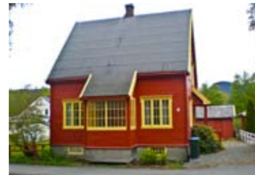
Ca. 1920- Njardar gate tidstypiske store vinduer som gir mye dagslys. Tradisjonell takpapp.
