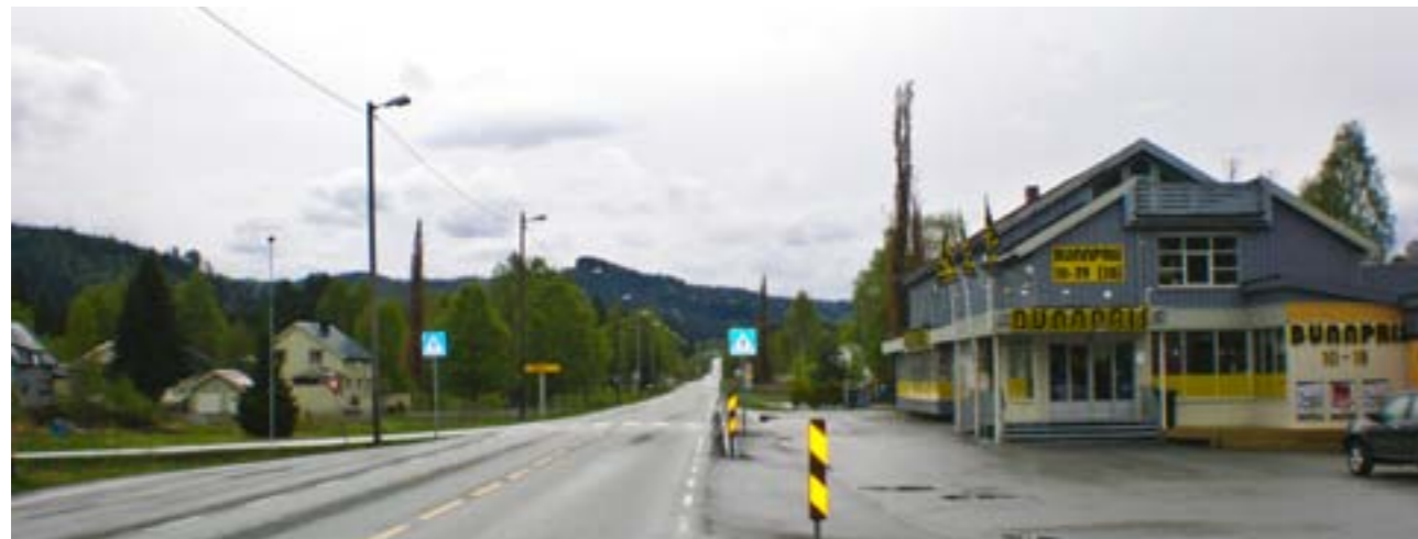
Udefinert tettsted med fylkesveg som hovedgate og spredt bebyggelse. Statens Vegvesens krav til byggeavstand gir et for åpent preg.
