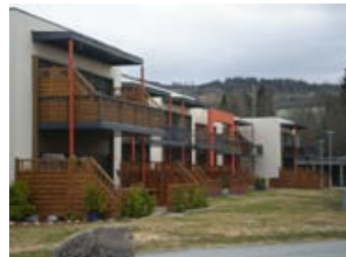
Flerfamiliebolig i 2 etasjer med fine dimensjoner og identitet. Leveggene er ettermontert.
