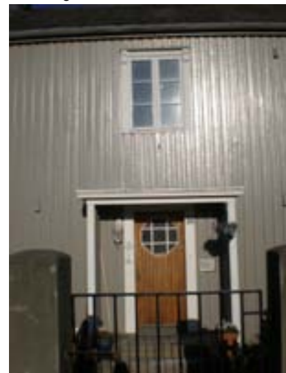
Opprinnelig vindusformat med sidehengslet 2-delt vindu med faste sprosser og 3 ruter, tidsriktig forfinet belistning, enkelt fint inngangsparti og inngangsdør.
