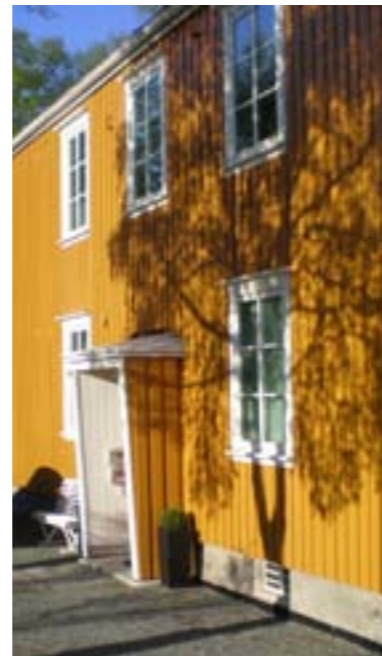
Enkelt og tilpasset inngangsparti, meget knapt takstikk sannsynligvis etterisolert.
