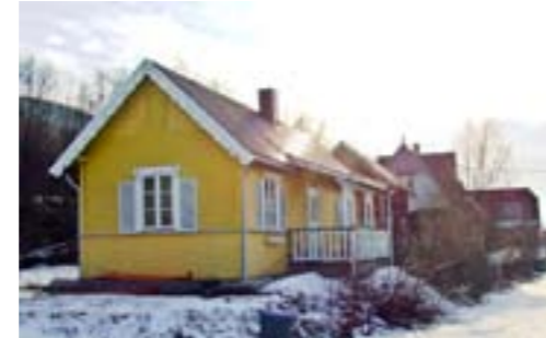
Ca. 1910- Thamshavn Ferdighus som utstillingshus på rekke
