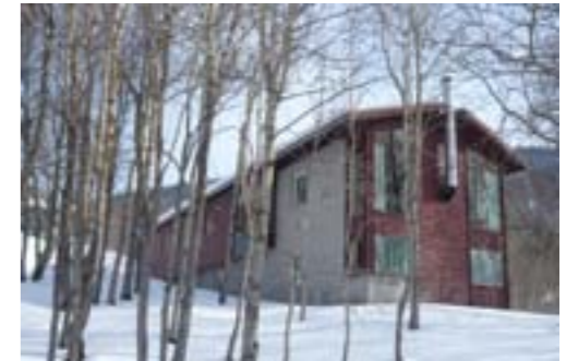
Ca. 1985- Hovsbakkan 1-2 etasjes spesielt bolighus utradisjonelt tilpasset terrenget, på tvers av kotene- tradisjonell takform med vellykket utradisjonell detaljering og materialbruk
