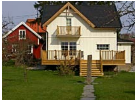
Samkjørt rekkverk på veranda og balkong- lett og åpent
