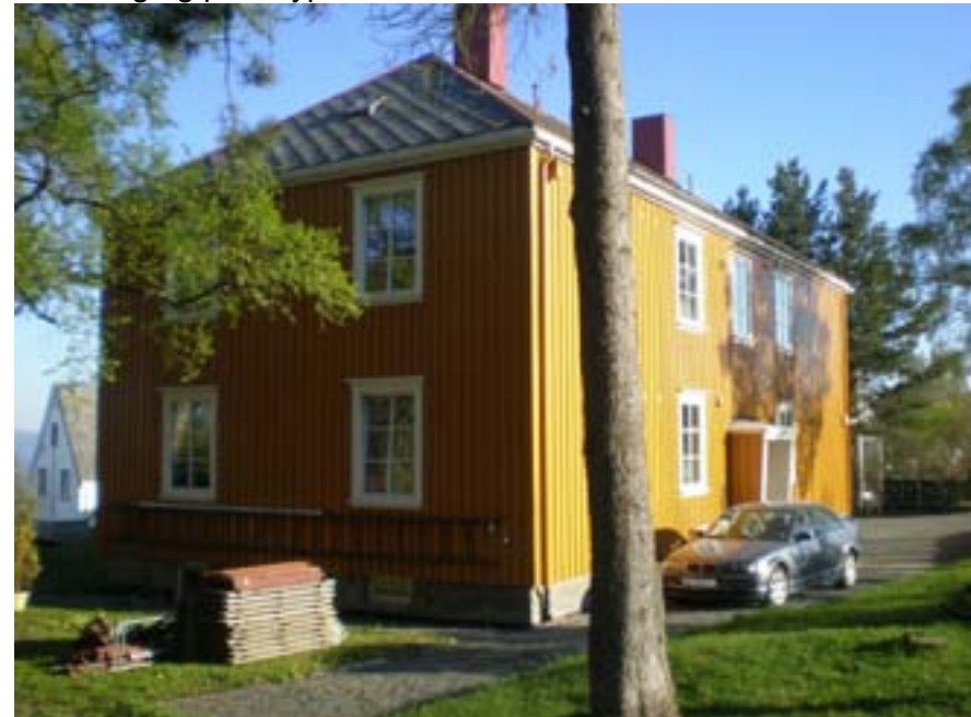
Kompakt knapp bygningskropp med profilert og høvlet tømmermannspanel. Vertikale vinduer bunnhengslet med løssprosser, som endrer vindusformatet i de 6 rutene med fin og enkel belistning.
