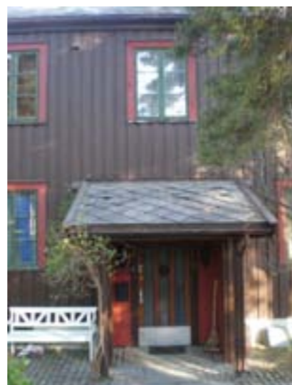
Opprinnelig tidsriktig vinduformat, belistning og hengsling. Luftigere, nyere inngangsparti, med skifer som hovedtaket.
