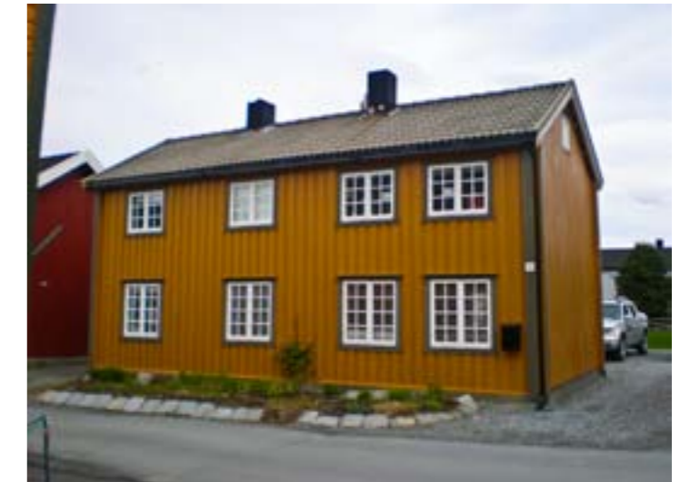
Bygningens form og uttrykk er enkelt og knapt og det er sammenheng mellom bygningens uttrykk og detaljer ved takutstikk og vindusbelistning.
