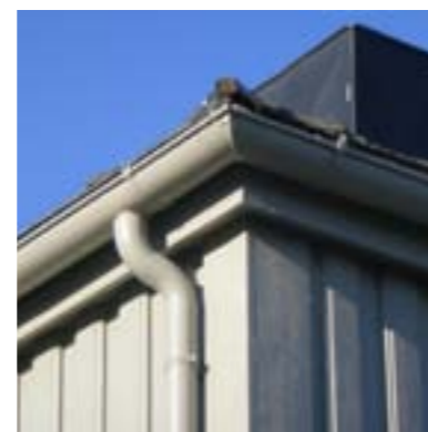
Typisk trøndersk knapt takutstikk. Ved etterisolering utvendig må takkonstruksjonen også forlenges.
