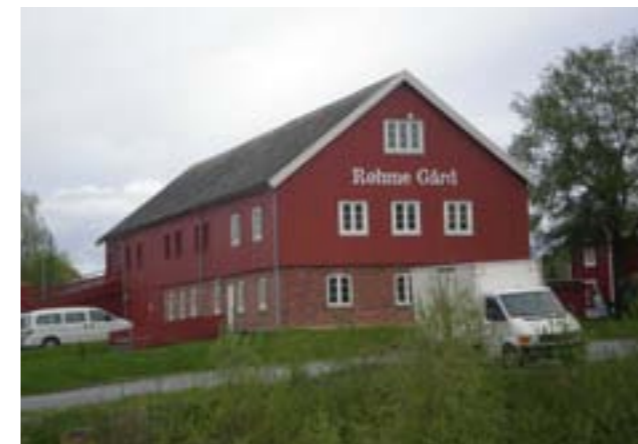
Godt eksempel på transformasjon fra låve til kontor. Eksisterende vinduer er beholdt hvitmalt, nye vinduer er røde.
